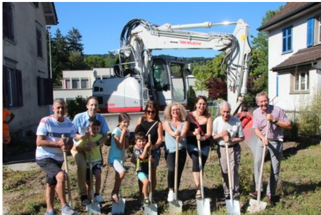
Bild: nw Vereinsmitglieder und Beat Curau (r.) am Spatenstich für den Umbau und die Erweiterung der Liegenschaft Freiestrasse 10.
